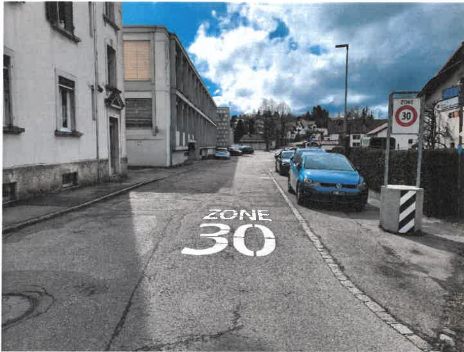
Figure 1 : Rue de la Côte – Rue résidentielle étroite avec signalisation existante de zone 30. On observe la configuration typique des rues du secteur Ouest, avec du stationnement latéral et une chaussée étroite nécessitant une modération de la vitesse. Cette rue est actuellement la seule du secteur en zone 30 km/h.
