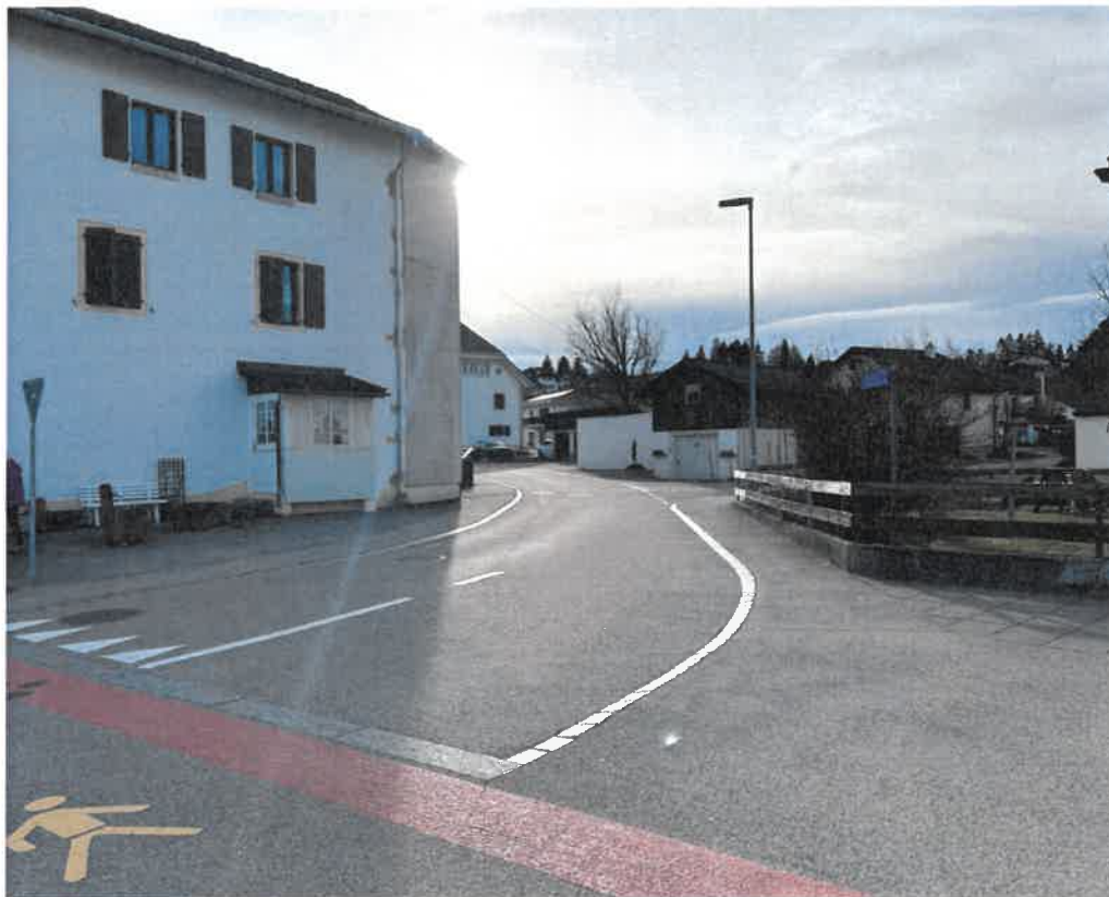
Figure 7 : Rue des Colverts – Secteur d'entrée et de sortie de la zone 30 km/h nécessitant la pose d'un totem et d'un marquage « zone 30 » au sol.
