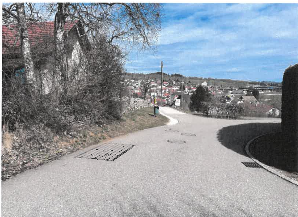
Figure 6 : Rue des Alisiers – Secteur nécessitant un marquage d'une bande piétonne afin d'identifier la continuité du cheminement piéton sur la partie médiane où le trottoir est absent.
